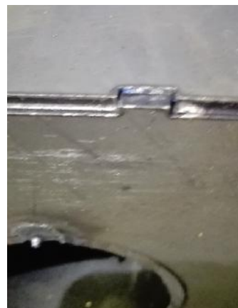
Рис. 3. Соединение типа «шип-паз»
